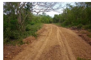
Ilustración 13. Mantenimiento de vía UOLG.
