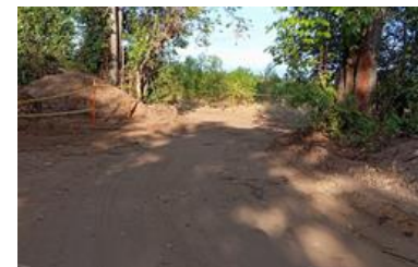
Ilustración 14. Mantenimiento de vía UOVN.
