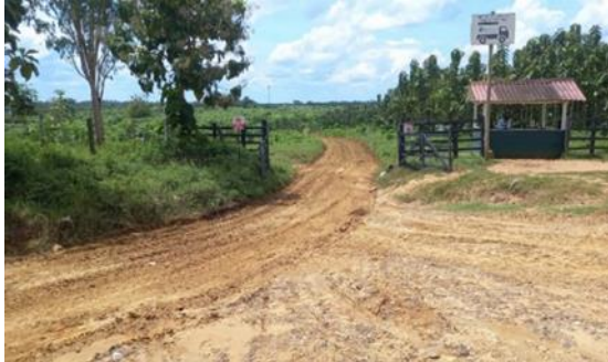
Ilustración 11. Mantenimiento de vía UOLG.
