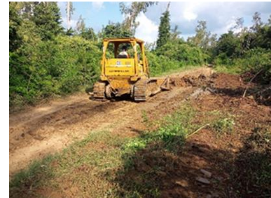
Ilustración 14. Mantenimiento Barrera Cortafuegos UOLG.
